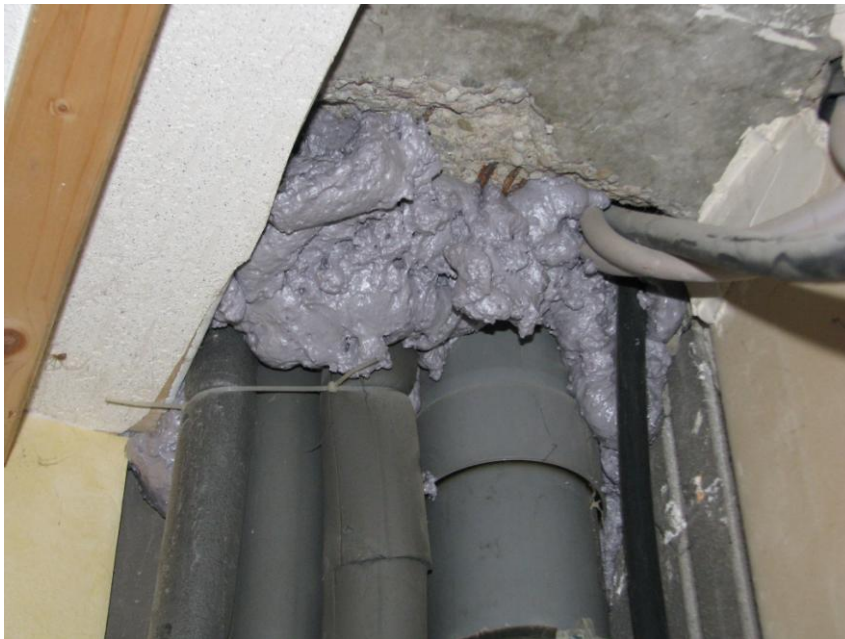
Bild 12 Einschäumung eines Versorgungsschachtes zur Vermeidung einer Kontaminationsverschleppung.
