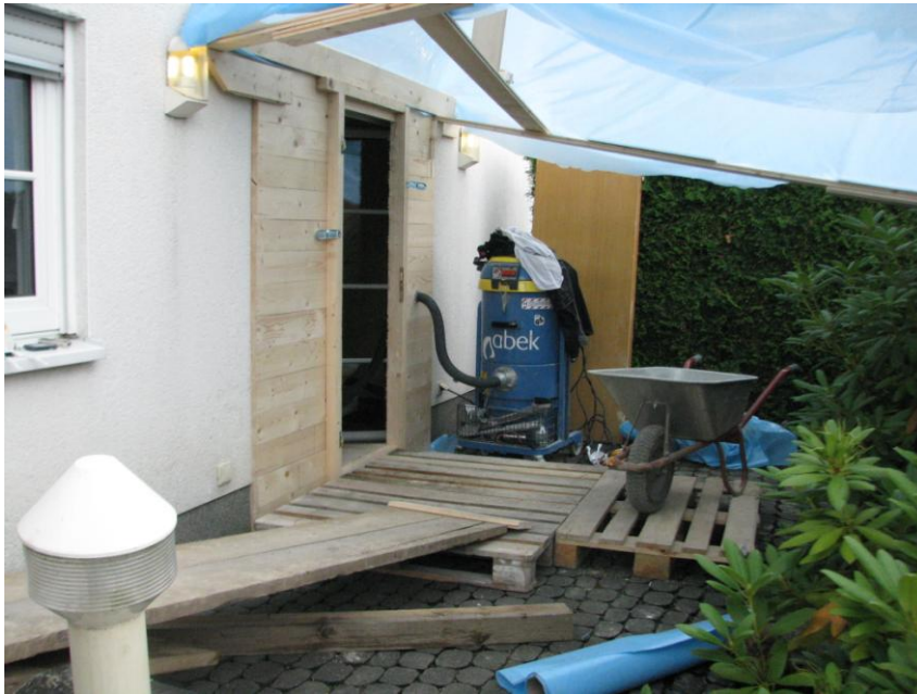
Bild 9 Einbau einer Bautüre mit der Durchführung einer Absaugung. Es handelt sich hier um die Terrassentüre des Schlafzimmers.
