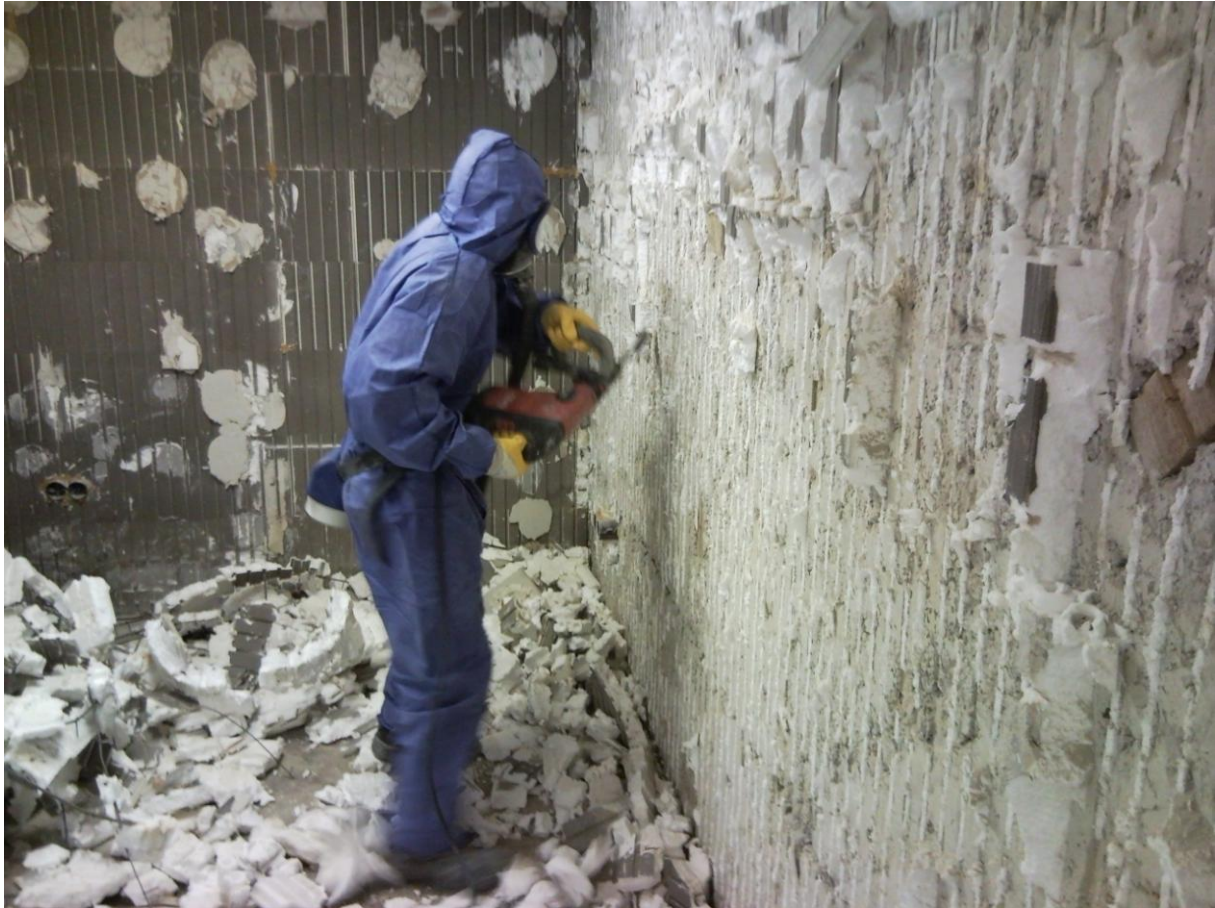
Bild 15 Abriss der inneren Polystyrolschalungsebene als Vorbereitung zur Innenabdichtung.
