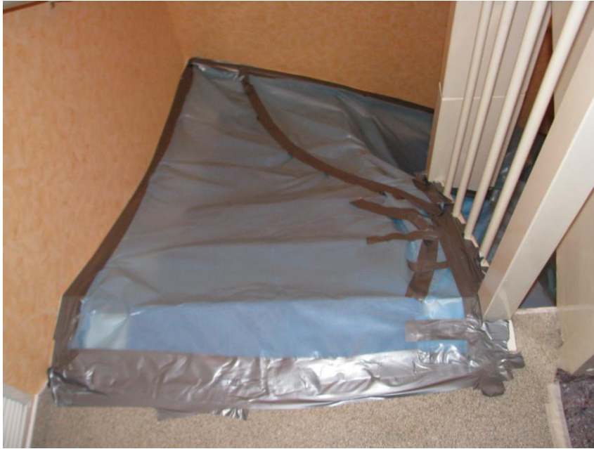
Bild 10 Abschottung der Kellertreppe zum Erdgeschoss mit Dachlatten, Klebband und Folie.
